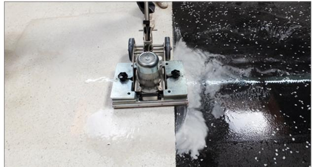
Bild 2: Test mit innovativer Reinigungsmaschine auf unterschiedlichen Terrazzobelägen
